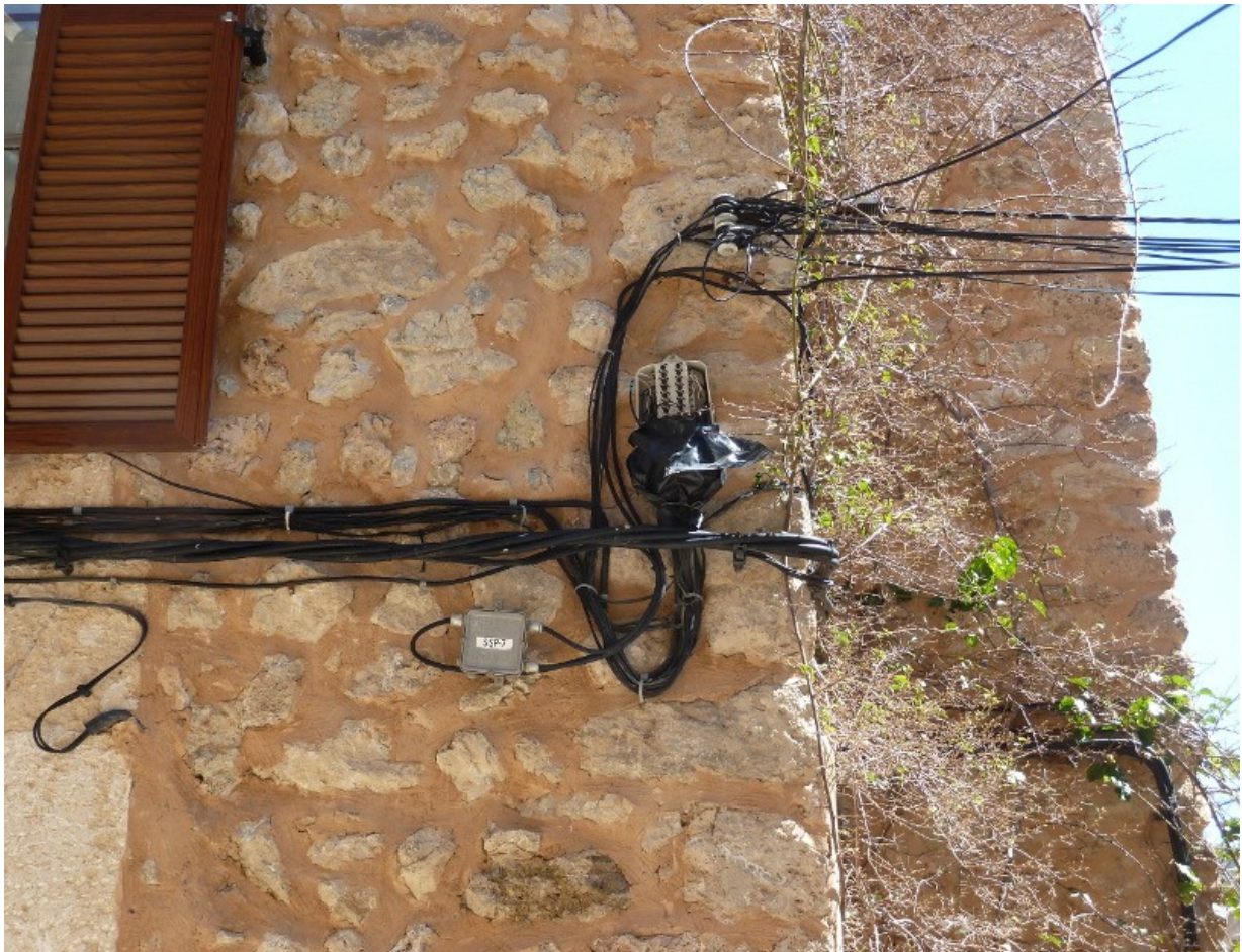
Stromkabel Verlegung auf mallorquinische Art in Valdemossa
